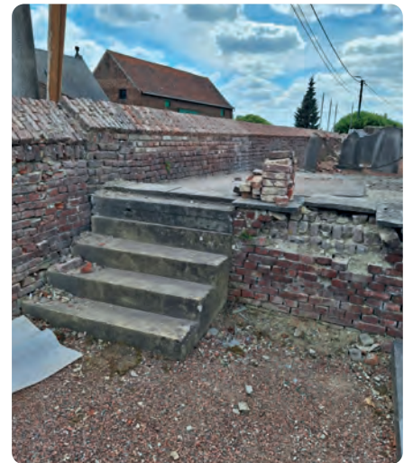
Restauratie van de authentieke kerkhofmuren in Bellingen, Beert en Heikruis
