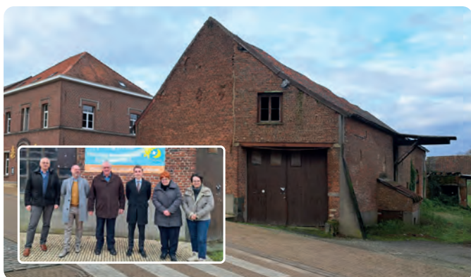
Schuur van Zagerij wordt een duurzame kinderopvang met voldoende ruimte voor werking Pinokkio en 't Zonnetje.
