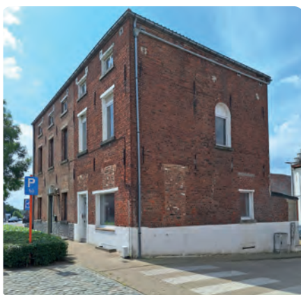
Aankoop en renovatie van noodwoning voor Pepingenaren in nood
